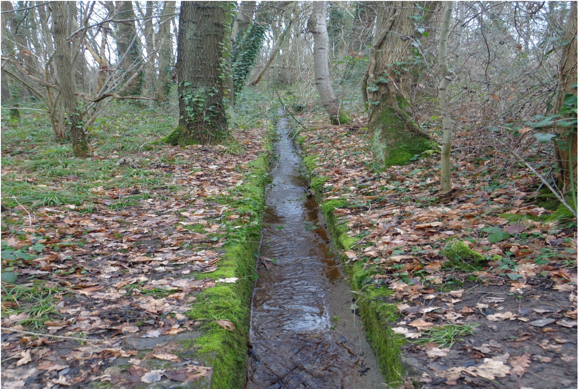
Canalisation par temps sec le long du viaduc. Photo P. Farret 22-01-2016
