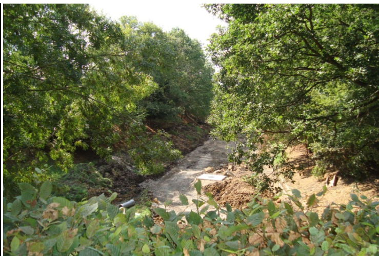
Bassin du Bois Carré à Chevry travaux d'Assainissement Photo P.Farret août 2018
