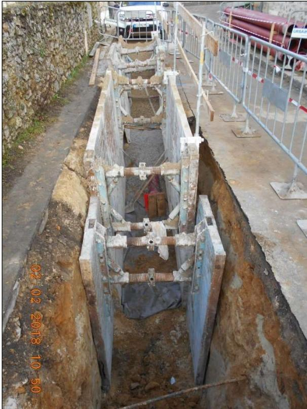
Figure 12 : Pose de canalisation - Rue du Moulin d'Aulne à Senlisse
